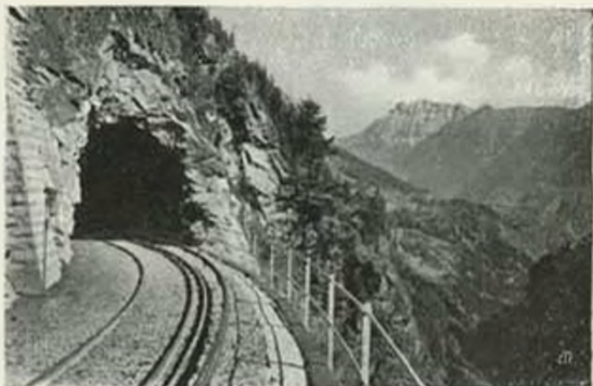
Ferrovia Martigny-Chatelard - Tunnel di Lachat.
