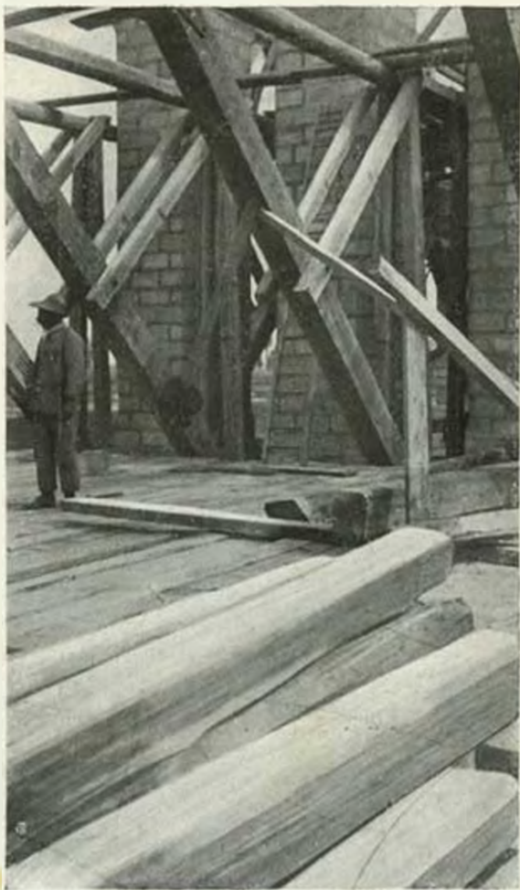
Per farsi un'idea della grandiosità del Ponte bisogna visitarne i dettagli, per esempio uno delle impalcature che sostengono la forma per gettare il calcestruzzo di una travata.
