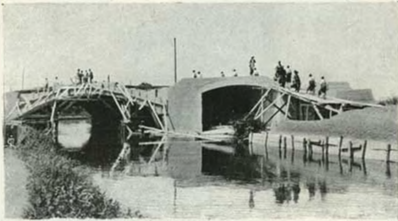
Ponte ferroviario in costruzione sul canale della Martesana.
