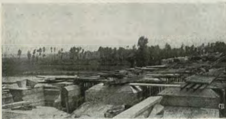
I cassoni di legno che hanno la forma negativa di una travata. In essi viene gettato il calcestruzzo intorno all'intreccio dei ferri.
