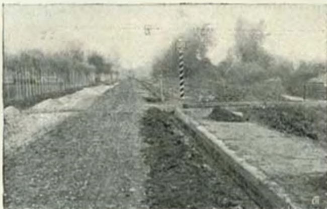
Veduta della strada Binasco-Coazzano-Rosate.
