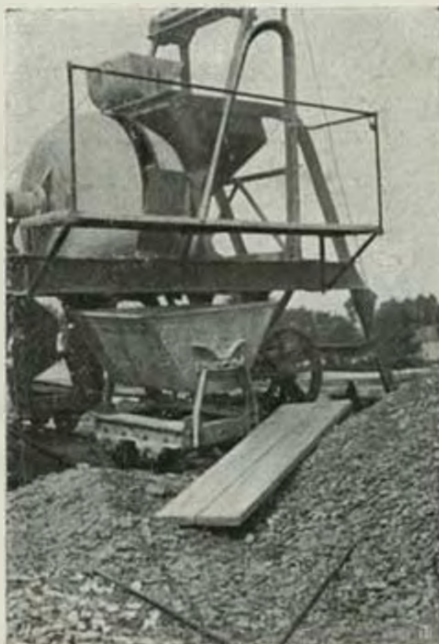
Una delle impastatrici con cui in 12 ore si manipola il calcestruzzo di una intera travata.
