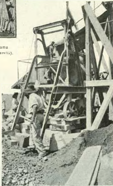
L'imposto del calcestruzzo al ponte della Murtesana (Fot. L. V. Bertarelli).
