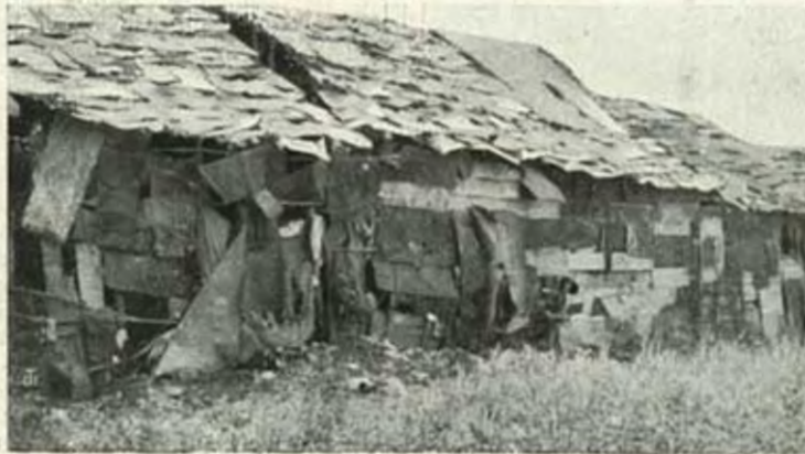
Costruzioni incredibilmente retrospettive (stracci o latte da petrolio spianate) che si vedono oggi al km. 3 da Milano sulla strada di Crescenazago. (Foto. L. V. Bertoldi).
