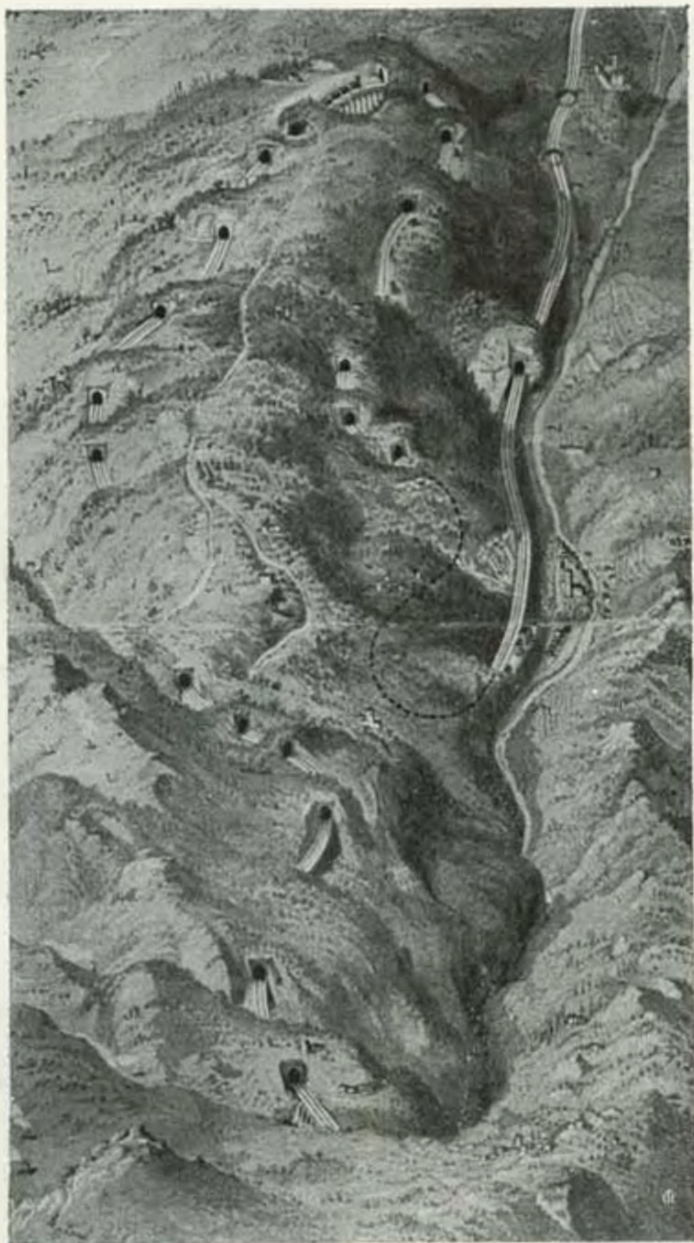
I fourniquets dell'attuale linea Porrettana Bologna-Firenze. (Da una stampa dell'epoca della costruzione, coll. G. Giustolisi).
