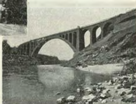
Salcano. — Viadotto sull'Isenzo.
