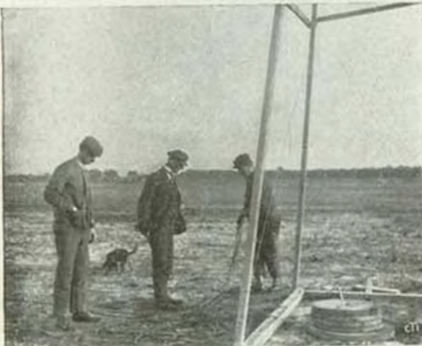
La corda scorrendo sopra carrucola si attacca con gancio ai pesi che vengono innalzati sul pilone mentre l'altro capo si fa scorrere lungo la rotaia e si attacca al pattino dell'aeroplano.
