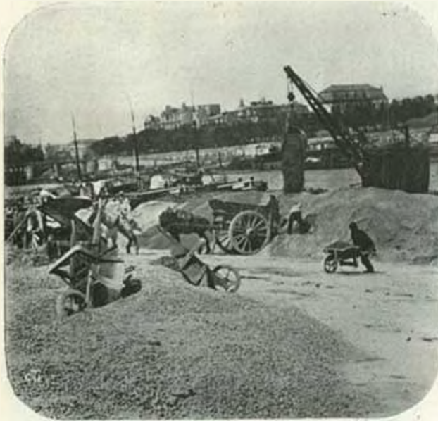
Scarico della sabbia poi terrapieni della Senna.
