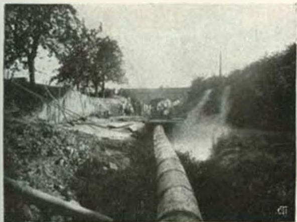
I lavori d'ingrandimento del sottopassaggio della ferrovia Bologna-Milano con sifono per le acque e costruzione di strada presso Castelfranco.
