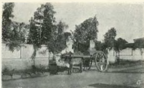
La penetrazione della civiltà. L'innalzamento delle strade di Asmara.
