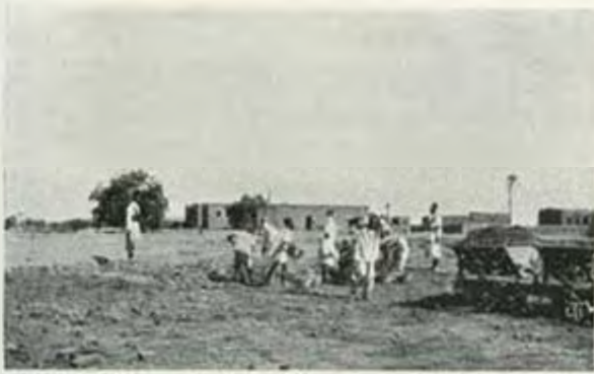
Galeotti alla costruzione di una strada, a Cassala. A destra e sinistra due ascari guardiani, con fucile o curbasch . Ogni galeotto ha una catena dalla cintola al collo di ciascun piede.
