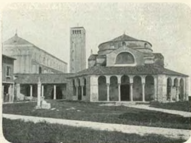
Le chiese dell'Isola di Torrello che destano qualche apprensione sulla loro solidità.
