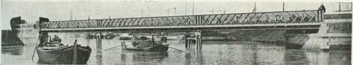
VENEZIA. — Ponte di ferro alla Stazione Marittima.
