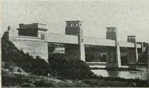
Ponte Britannia sullo stretto di Menai.
