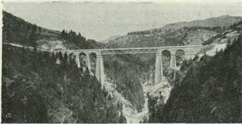
Il ponte Roana-Asiago, sulla Val d'Assa.
