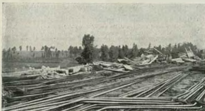
Aspetto del piano superiore di una travata coperta dai ferri preparativi per formare la travata contigua.
