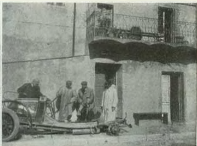
Lo scheletro d'un automobile incendiato sulla strada dell'Abetone
