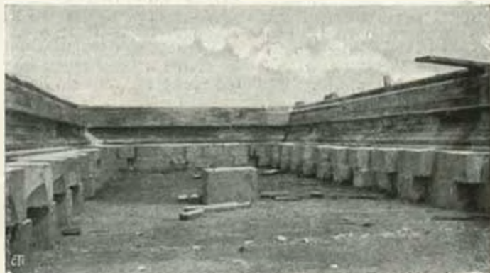
Piano superiore di una pile spalla contornata dai blocchi che formano la radice delle sagome.
