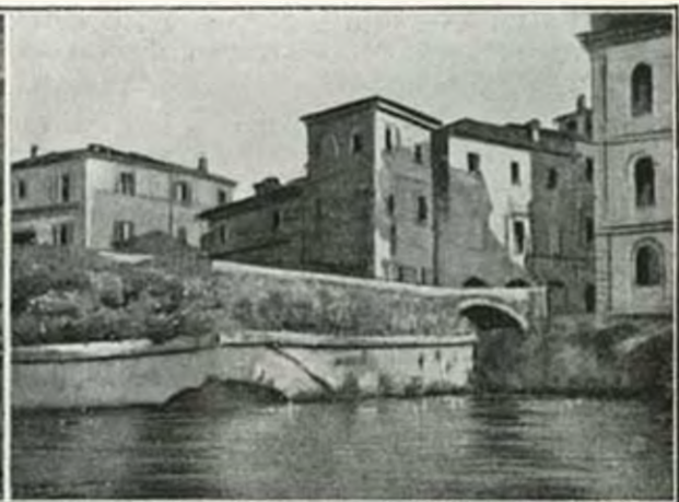
(Fot. Ministero A. I. e C.) Un ponte romano sul Velino, a Rieti.
