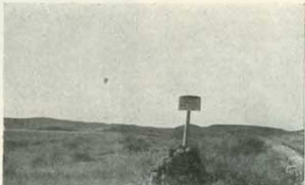
Tipo di cartello indicatore stradale: Bivio di Teramni-Dek-Amerò, Km. 32,740. Sulla destra la carrozzabile da Adl-Ugri a Sagabelli regolarmente mantenuta, con cigli e fossati e diserbata.
