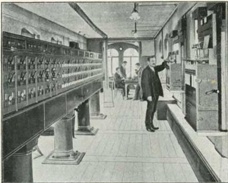
Cabina centrale elettrica della Stazione di Dresda.
