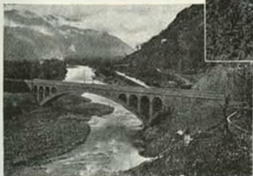
Ponte sull'Adda, presso Morbegno.
