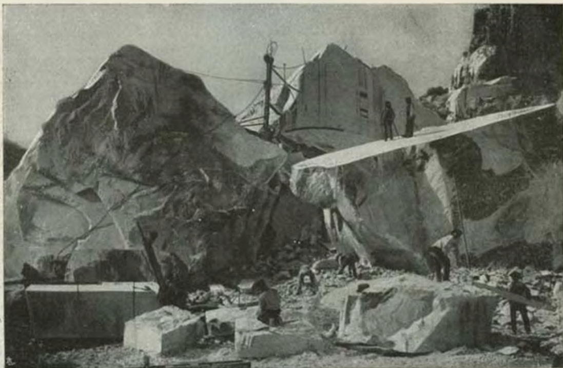
Taglio del marmo col filo elicoidale (Cave di Gioia, Carrara). Questo modo di tagliare i blocchi ha sostituito molta parte delle mine. Consiste nel tagliare la roccia in sito mediante un filo d'acciaio teso sul taglio, con acqua e sabbia e fatto girare su puleggie mosse da forza elettrica. In un giorno si arriva a sprofondare di 1 o 2 metri un taglio lungo anche quindici metri o più.
