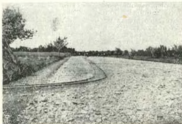
Una delle grandi strade larghe 20 metri, lunghe cinque chilometri, in costruzione. (Pia. Arch. Rigo).
