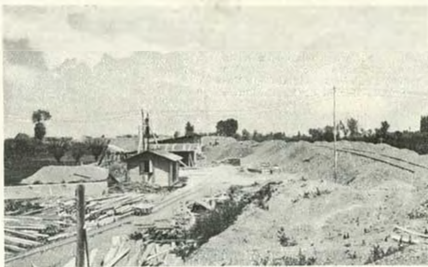
La costruzione di un argine ferroviario di raccordo per la nuova Stazione di Milano (Linea Como-Gottardo). (Pia. E. V. Boffardi).
