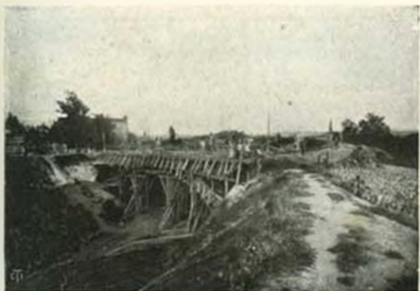
I lavori di «rettifica» del ponte sul Lavino.
