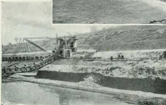
Escavatori dei lavori di sistemazione del Canale Maestro.
