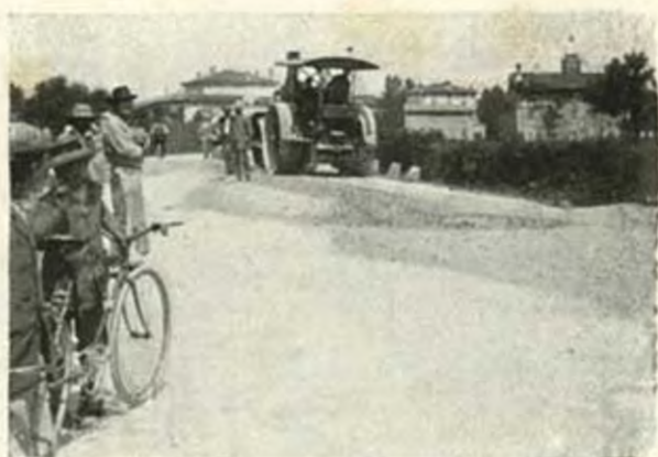
I lavori di cilindatura della strada.
