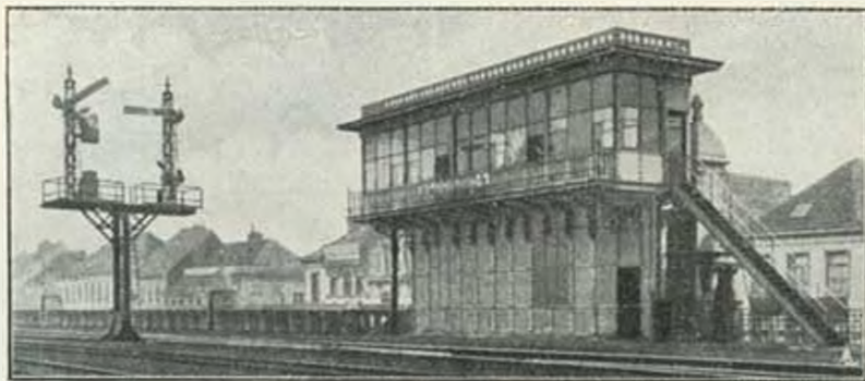
Cabina centrale e grande semaforo della stazione principale di Anversa.
